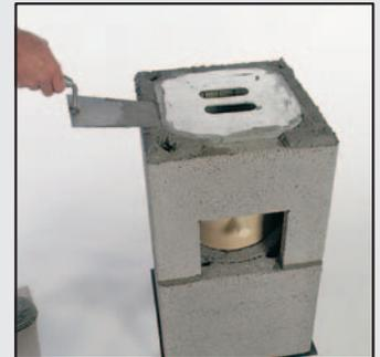
8 Используя шаблон, предохраняющий внутреннее пространство дымовой трубы вместе с каналами проветривания от попадания раствора, нанесите на блок необходимое количество раствора.
