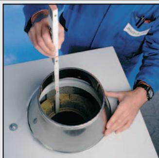
46 Установите конус и измерьте требуемую высоту последнего элемента внутренней керамической трубы.
