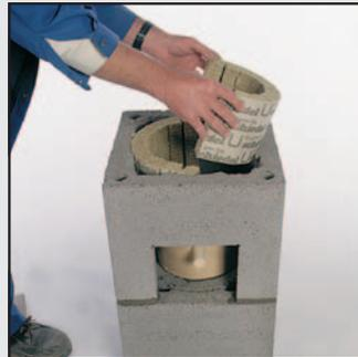
7 Следите за тем, чтобы изоляционный материал не засорил каналы вентиляции дымохода. Трубопровод для отвода конденсата выведите в отверстие вентиляционной решетки, а затем подключите к системе канализации.
