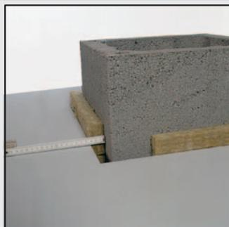
35 При монтаже дымохода через перекрытие подготовьте отверстие в конструкции на 3 см больше, чем наружный размер каменной оболочки дымохода. Этот промежуток заполните негорючим изоляционным материалом.
