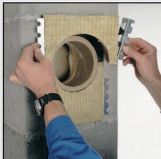
30 Прикрепите к изоляционной панели металлические фиксирующие уголки, а затем установите панель в отверстие.
