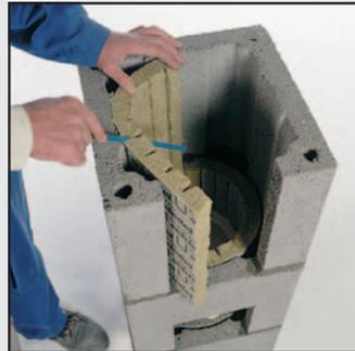
10 Блок установите на раствор, излишки раствора удалите. Изоляционные панели прорезями внутрь вставьте в каменный блок так, чтобы соединение двух элементов изоляции находилось посередине задней стенки. При помощи пилки отрежьте излишки изоляционного материала вдоль каналов проветривания дымохода.
