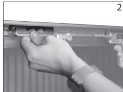
**Этап 3:** Протолкните внутрь металлическую защитную планку с левой и с правой стороны. (На угловой модели достаточно протолкнуть внутрь защитную планку большого стекла. На 3-сторонней модели этот этап следует пропустить.)
